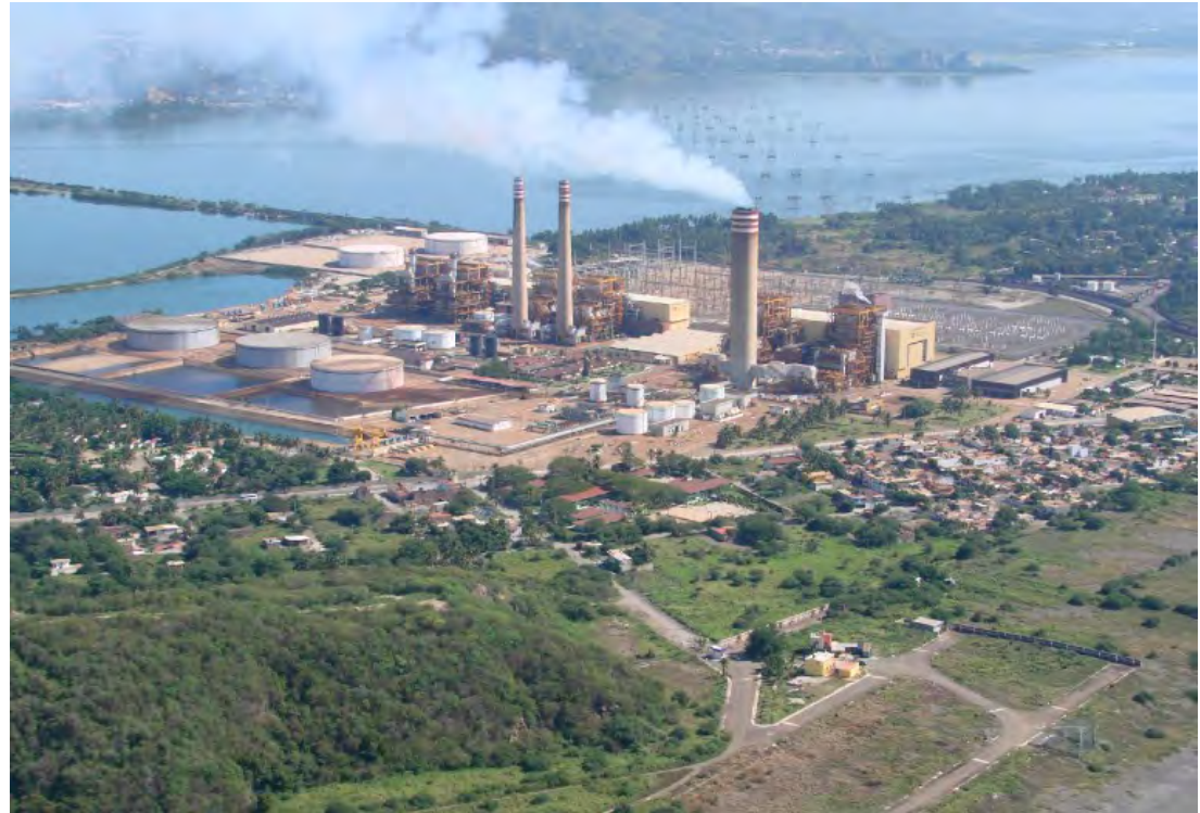
Fotografía de Termoelectrica "Gral. Manuel Álvarez Moreno". Manzanillo, Colima. Recuperada de http://ipuntocom.mx/82491/se-restablece-energia-en-termoelectrica-de-manzanillo-con-gas-natural/
