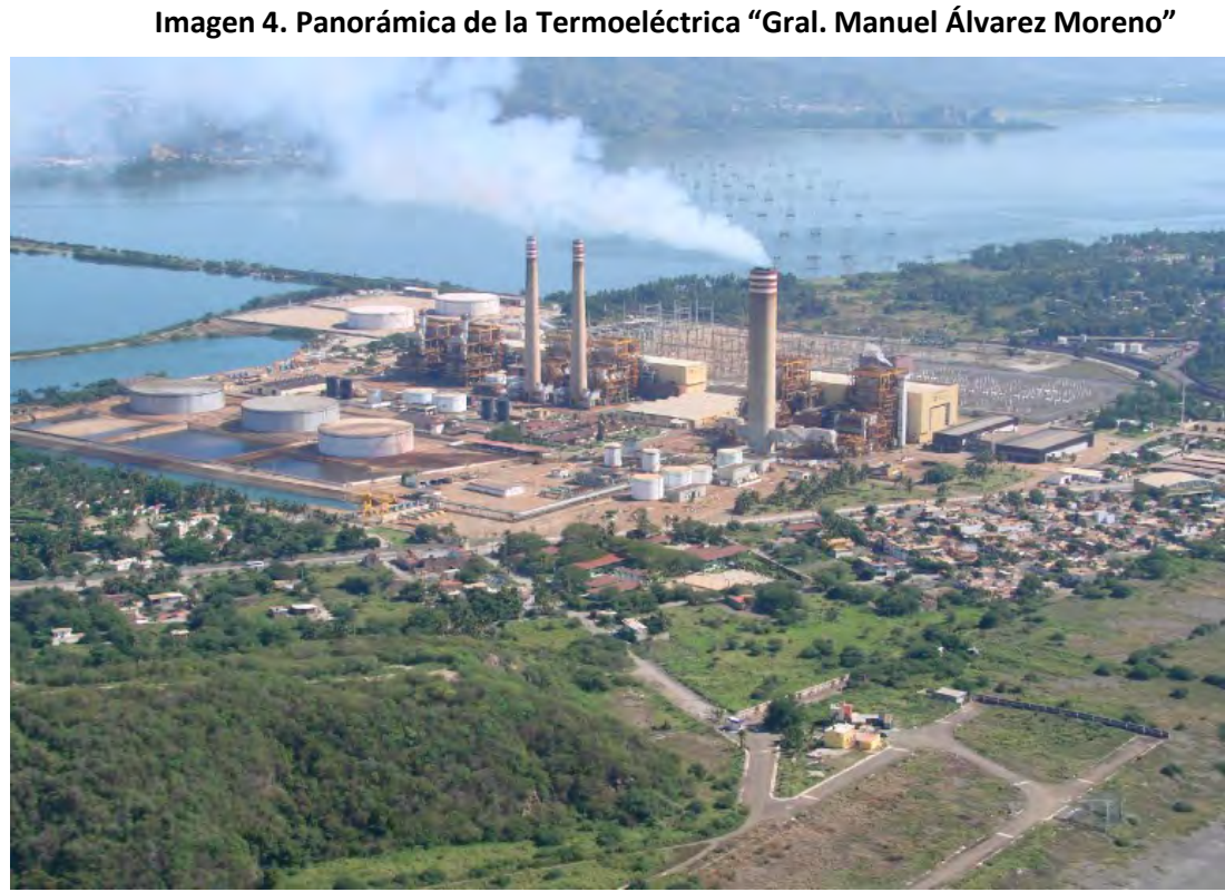
Fotografía de Termoeléctrica "Gral. Manuel Álvarez Moreno". Manzanillo, Colima. Recuperada de http://ipuntocom.mx/82491/se-restablece-energia-en-termoelectrica-de-manzanillo-con-gas-natural/
